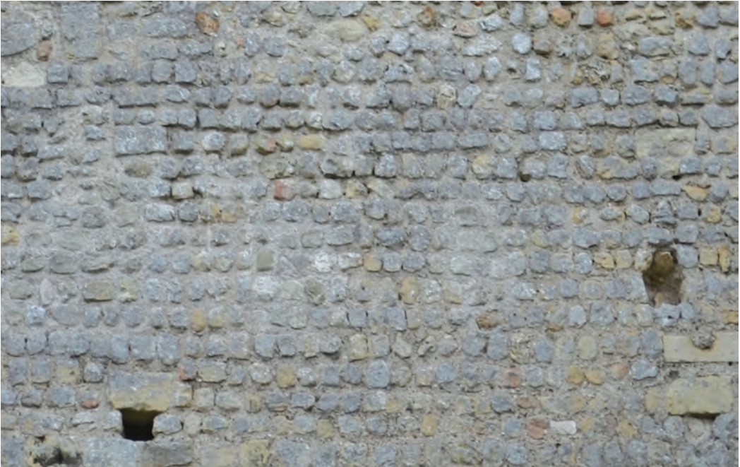
Fig. 4.4. Langeais (Indre-et-Loire) Petit appareil in the donjon (c. 1000).
